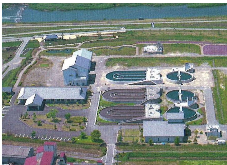
球磨川上流浄化センター(錦町大字一武字平岩 70-1)〈建設時〉
