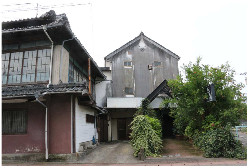
通りより見る（左手前の建物が主屋）
