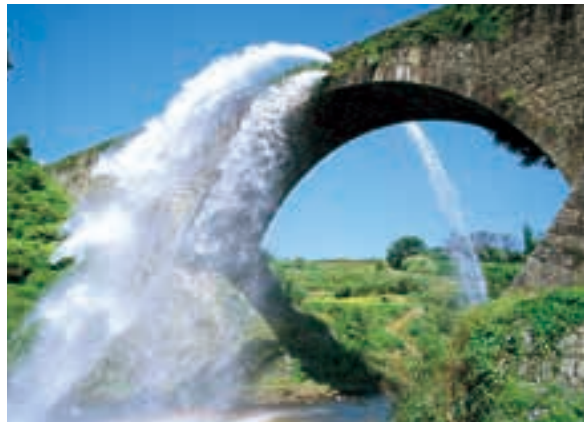
豪快な放水が特徴の通潤橋(山都町)は、観光資源の代表格として見学旅行の定番となっています。道の駅や通潤橋史料館も隣接しているので、これからも緑川流域の石橋観光の拠点の一つとして期待されています。
