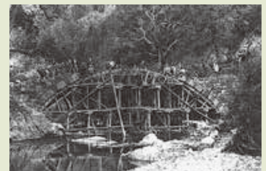
アーチ式石橋の架橋の様子が分かる貴重な写真 提供: 東陽 石匠館
