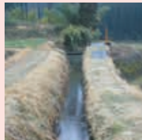
立野橋は水路橋として田畑を潤す。
