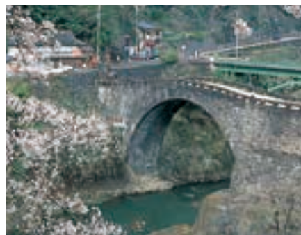
単一アーチ式の石橋として日本最大級の霊台橋の工事には、述べ43,967人が携わったという記録が残っています。
