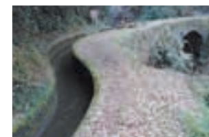
水路橋 (雄亀滝橋)
