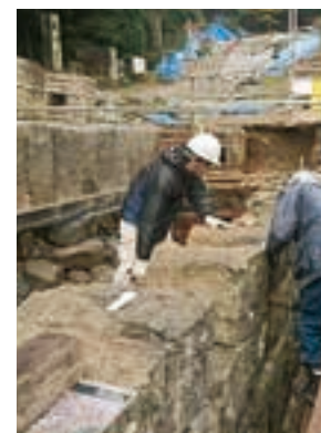
平成28年10月から令和2年5月の修復工事の様子。崩落した93石を含む148石を積み直しています。
