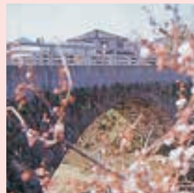
浜町橋は旧矢部町の中心地に架かる交通の要。
