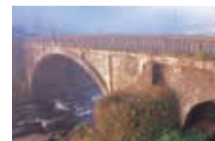
2連アーチ橋 (金内橋)
