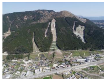
【治山事業による復旧状況】
