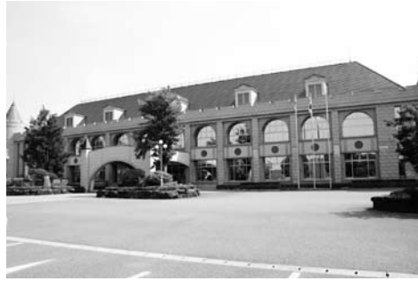
(美里町中央庁舎)
