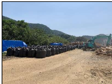
大型土のう製作
