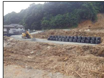
大型土のう設置
