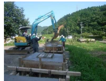
基礎コンクリート型枠打設
