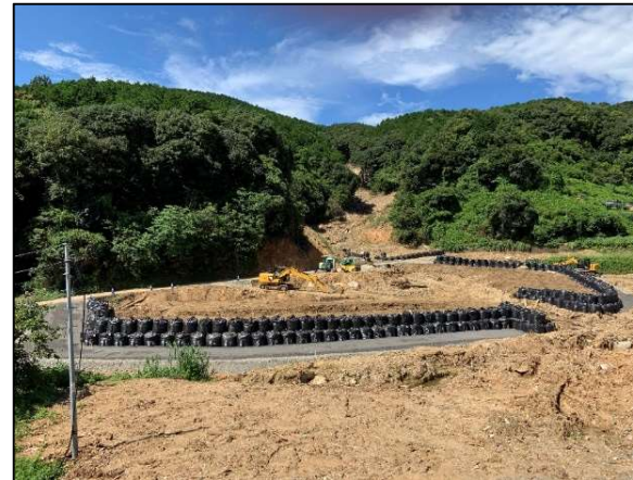
応急対策完了全景
