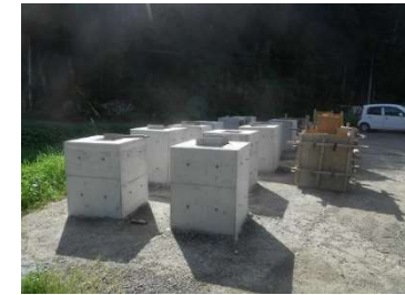
基礎コンクリート型枠完成
