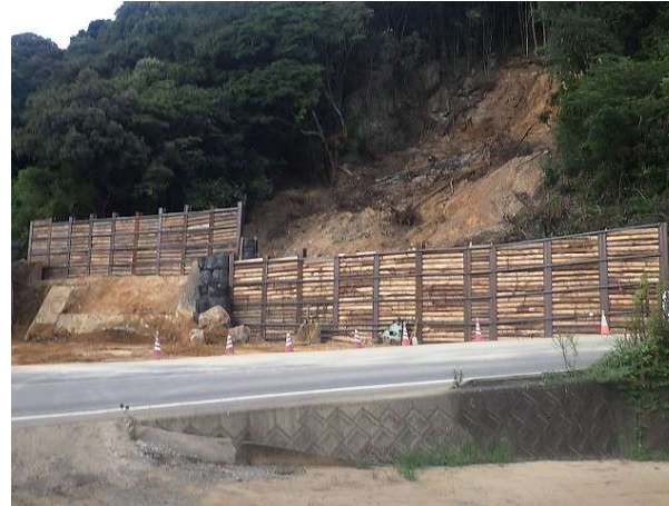
応急対策完了全景
