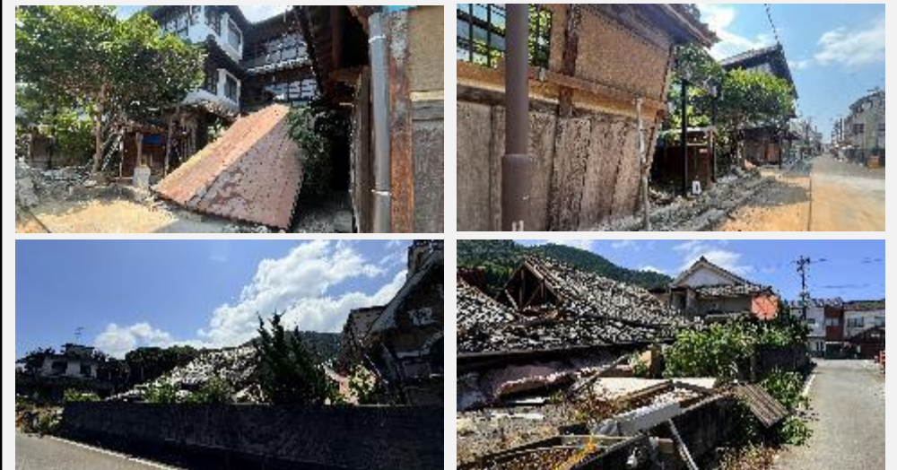
日奈久温泉街の被災状況
