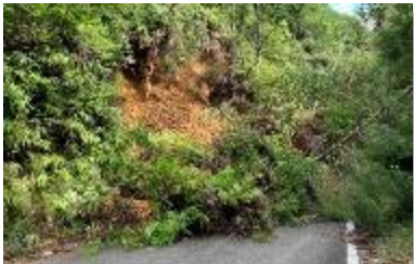
林道の法面崩壊（八代市）
