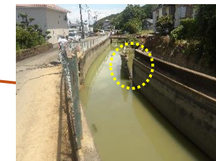
不知火幹線水路の 崩壊（八代市）
