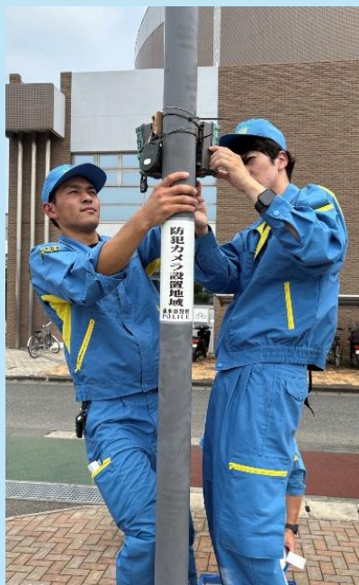
被災地への防犯カメラの設置
