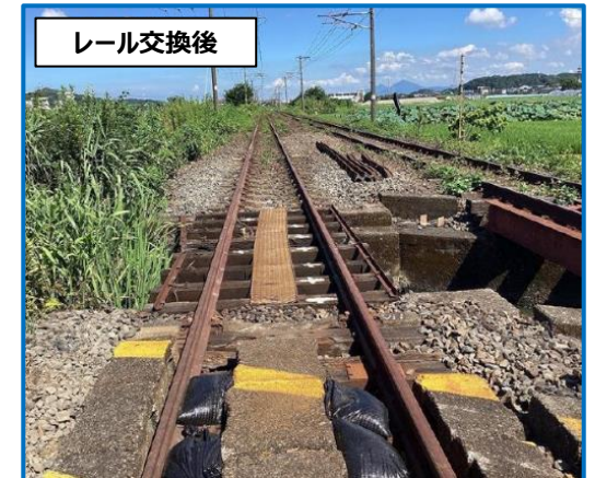
【松橋・小川間】損傷レール交換
