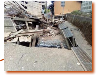
↑幹線用水路の沈下 （氷川町）
