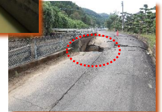
不知火幹線水路の 崩壊（八代市）
