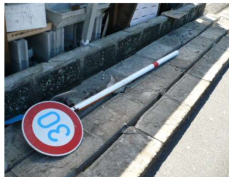
交通安全施設(道路標識)
