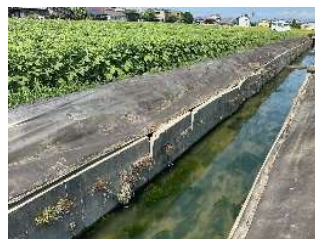
②排水路の損傷(八代市)
