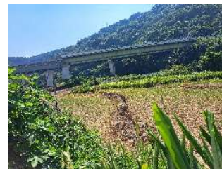
①農地の亀裂(八代市)
