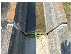
用水路の補修
