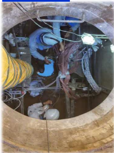
復旧MH対処
