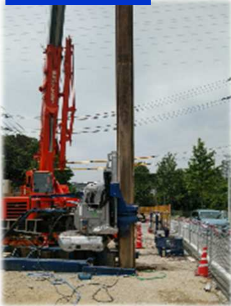
矢板打込工事
