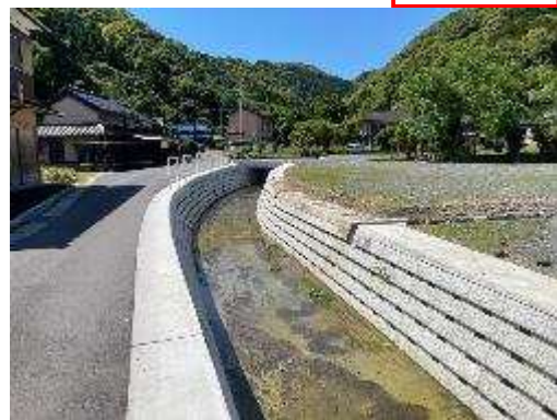
【道川内川】 拡幅工事
