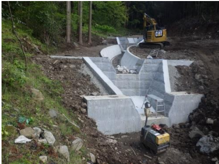
溪流保全工施工状況(中登川)
