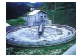
畜産環境対策施設
