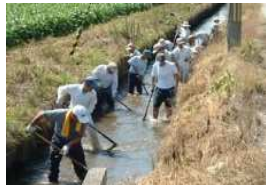
水路の泥上げ
