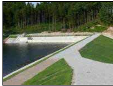
改修後のため池
