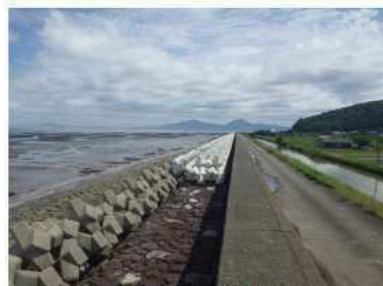
消波ブロック整備状況
