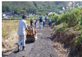
農道のアスファルト舗装
