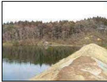
改修前のため池
