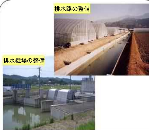
(事業実施) 排水機場、排水路の整備により、湛水被害の防止や地下水位の低下を図る。
