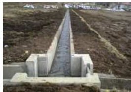
コンクリート水路への更新
