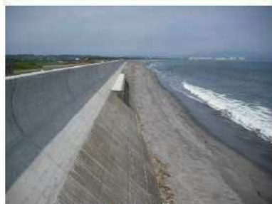
堤防整備状況
