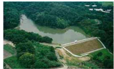
整備されたため池の全景
