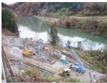
地すべり対策工事の実施
