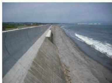
堤防整備状況
