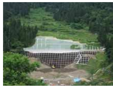
地すべり対策工事の完了
