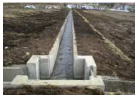
コンクリート水路への更新
