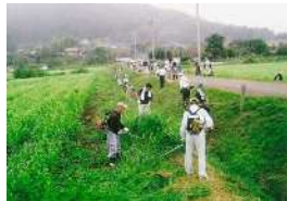
法面の草刈り
