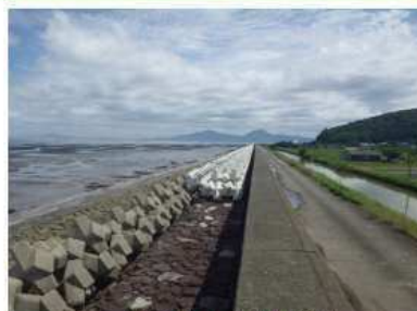
消波ブロック整備状況
