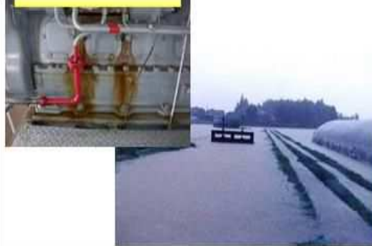
機器からのオイル漏れ
