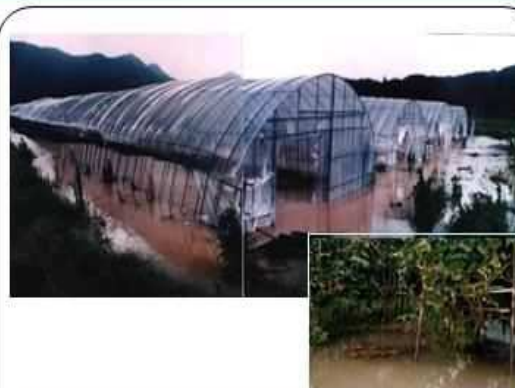
(事業実施前) 排水条件が不良で湛水被害が生じている農地
