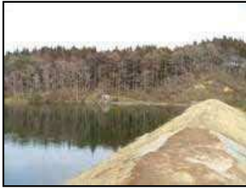
改修前のため池
