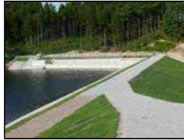
改修後のため池
