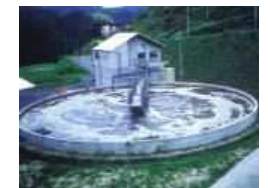
畜産環境対策施設
