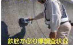
鉄筋かぶり厚調査状況
