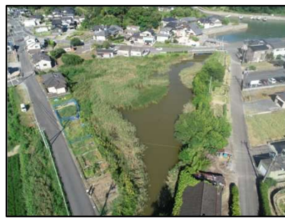
(2) 大矢野町中地区排水池
