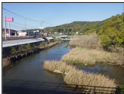
(1) 松島町合津地区排水池
