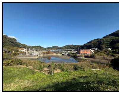
(3) 大矢野町上地区排水池
