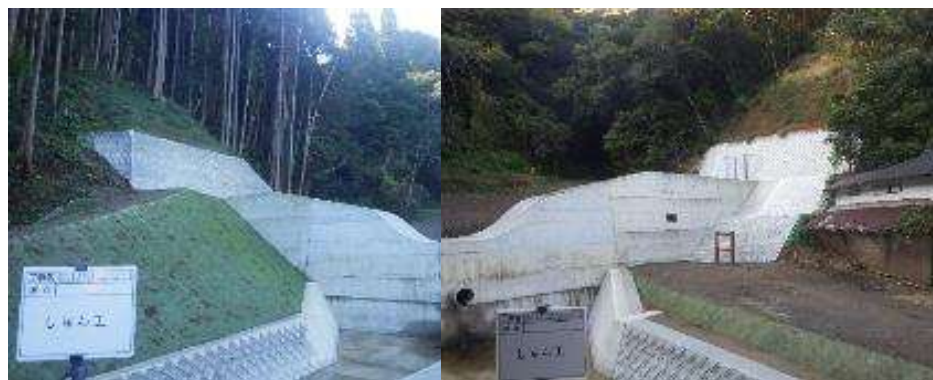
西川内川 砂防堰堤(完了)
