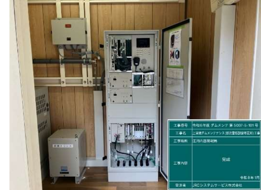
上津浦ダム 放流警報設備更新
