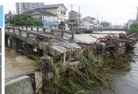
(祇園橋の被害状況)
