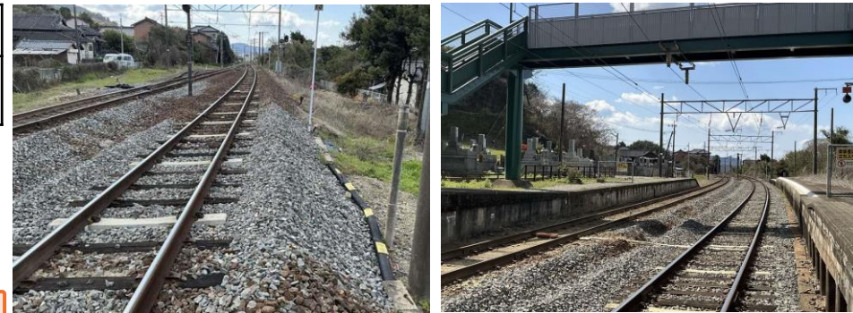
(R8.3.13肥後高田駅近くの状況)
