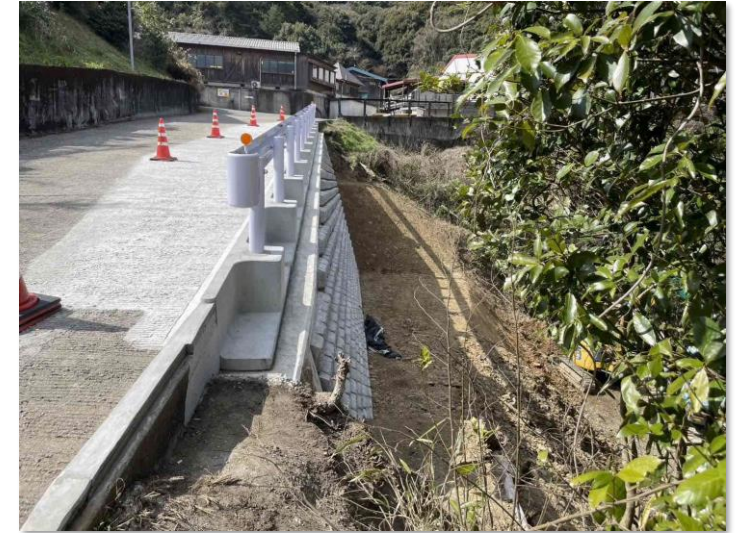
被災した製材所搬入路の復旧状況 （上天草市）
