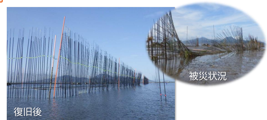
破損したあさり保護区の復旧（熊本市）
