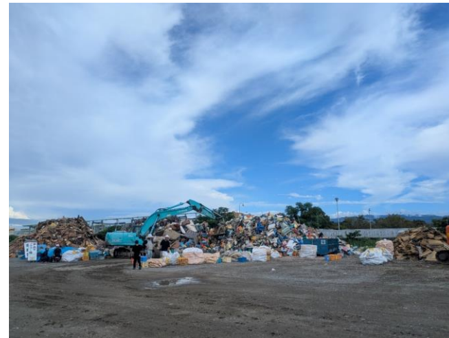
(災害廃棄物仮置場の状況) 【R7.9月 八代市】
