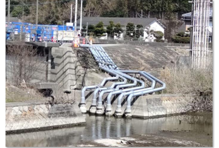
応急ポンプの設置状況 (上天草市)
