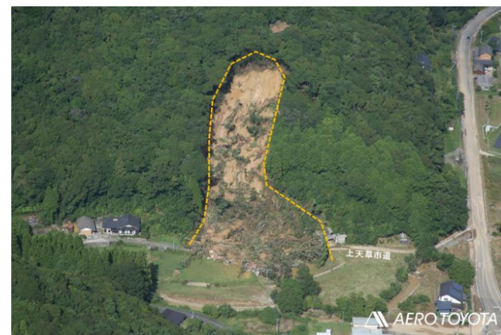
災害関連緊急治山事業（上天草市）
