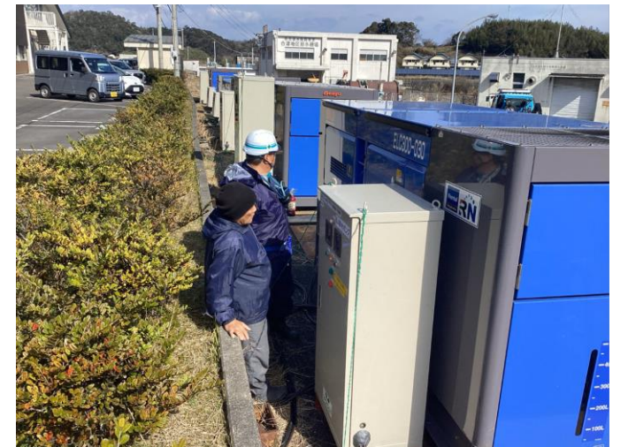
既設機場の仮復旧工事の状況 (上天草市)
