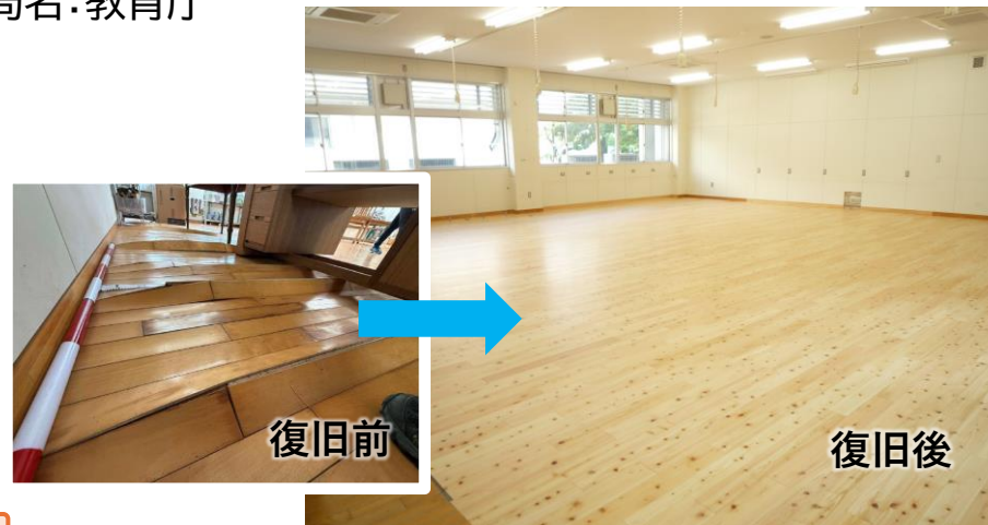
(県立八代中学校校舎の復旧の状況)
