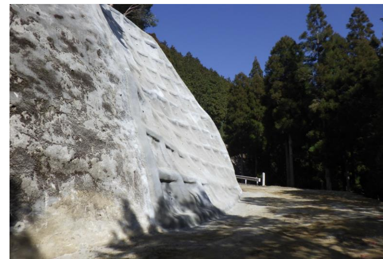
林道の法面復旧完了（五木村）
