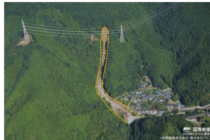
災害関連緊急治山事業（八代市）
