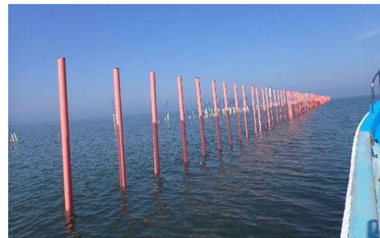
再設置した漂流物対策フェンス(熊本市)
