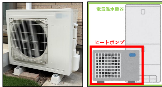
エアコンディショナーの室外ユニット 及び電気温水機器のヒートポンプ
