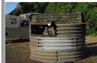
防護施設の構築
