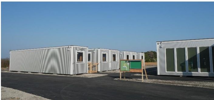
上天草市の建設型応急住宅（ムービングハウス）
