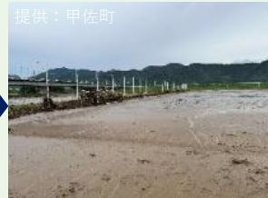
施設破損・土砂堆積状況
