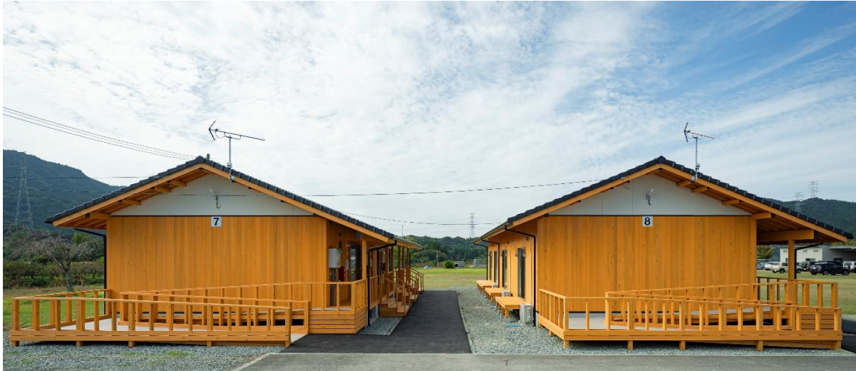
美里町の建設型応急住宅（木造）
