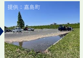
土砂撤去状況
