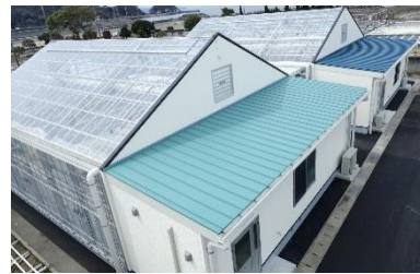
海藻研究棟の整備
