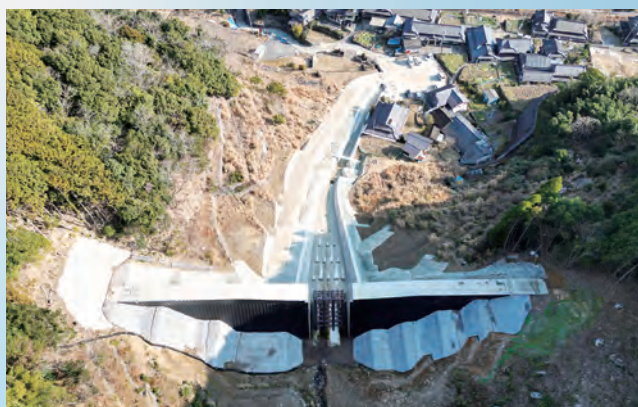
簸瀬川(えびらせがわ)砂防えん堤整備(芦北町)
