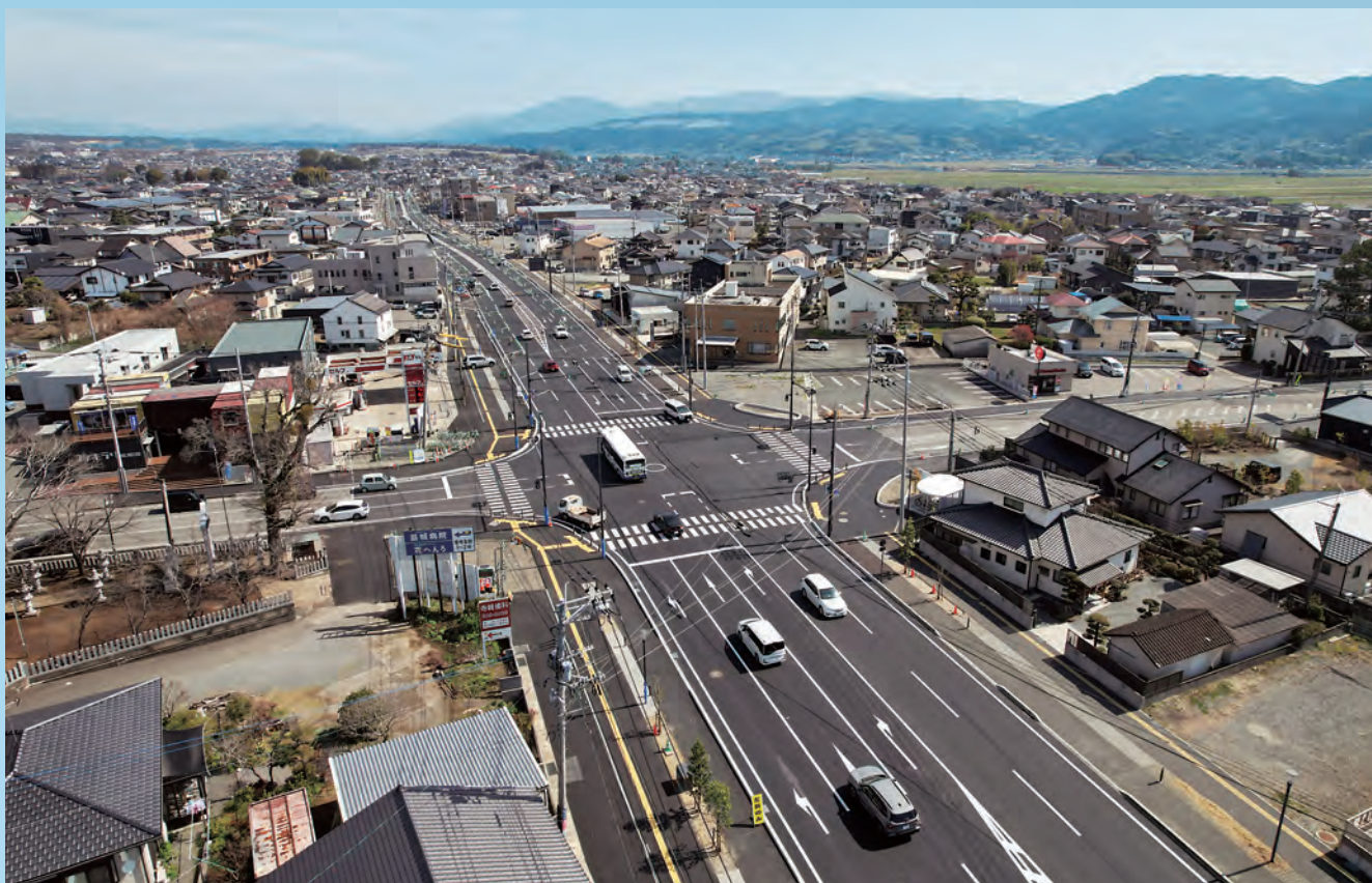
県道熊本高森線4車線化(益城町)
