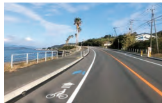
矢羽根など路面標示の設置 (走行環境整備の例)
