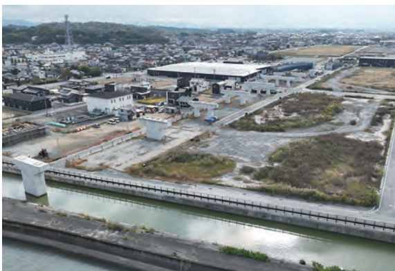
有明海沿岸道路「三池港IC 連絡路」整備状況(荒尾市)
