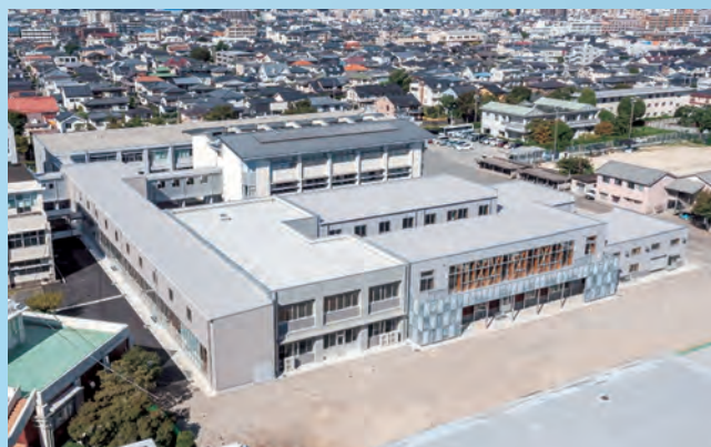
熊本工業高校実習棟改修(熊本市)
