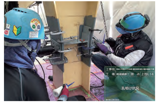
老朽化した橋りょうの補修工事
