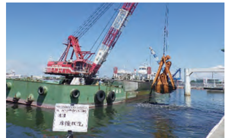
水深の確保(浚渫状況)
