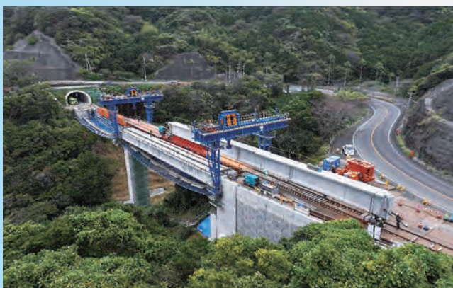
国道389号下田南バイパス工事(天草市)
