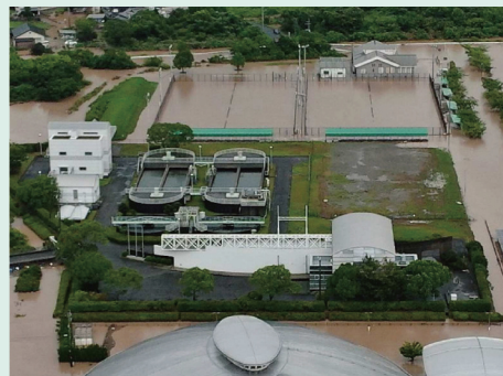
令和7年8月豪雨で浸水した下水処理場（上天草市）
