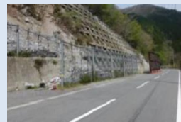
【道路】落石防止柵の設置
