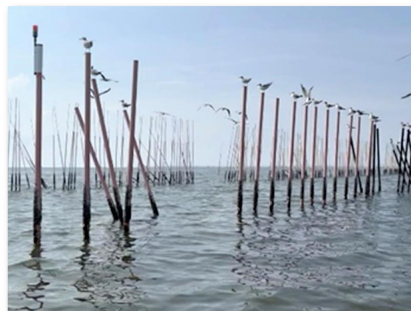
倒伏・流失したフェンス(熊本市)
