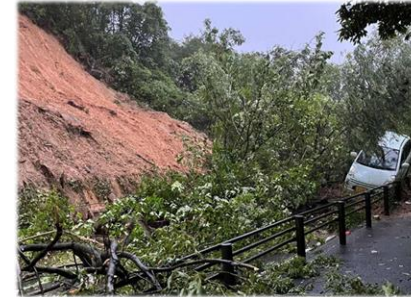
法面崩壊 (上天草市)
