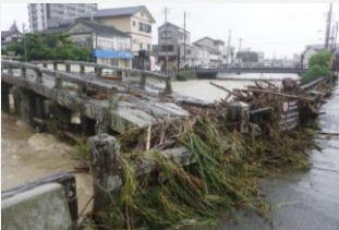
▲祇園橋の被害状況
