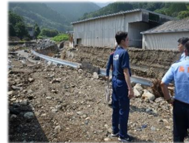
越水土砂流出被害 (美里町)
