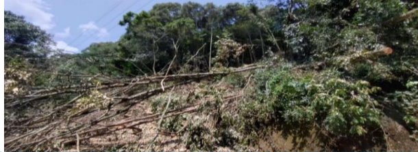
道路（防災対策未実施）
