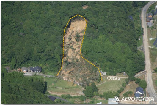
山腹崩壊(上天草市)
