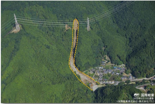
山腹崩壊(八代市)
