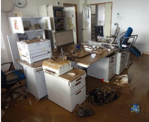
交番の被害状況
