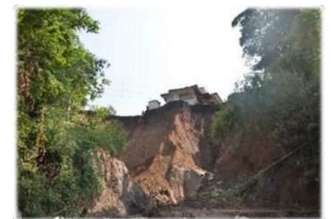
急傾斜崩壊被害 (美里町)
