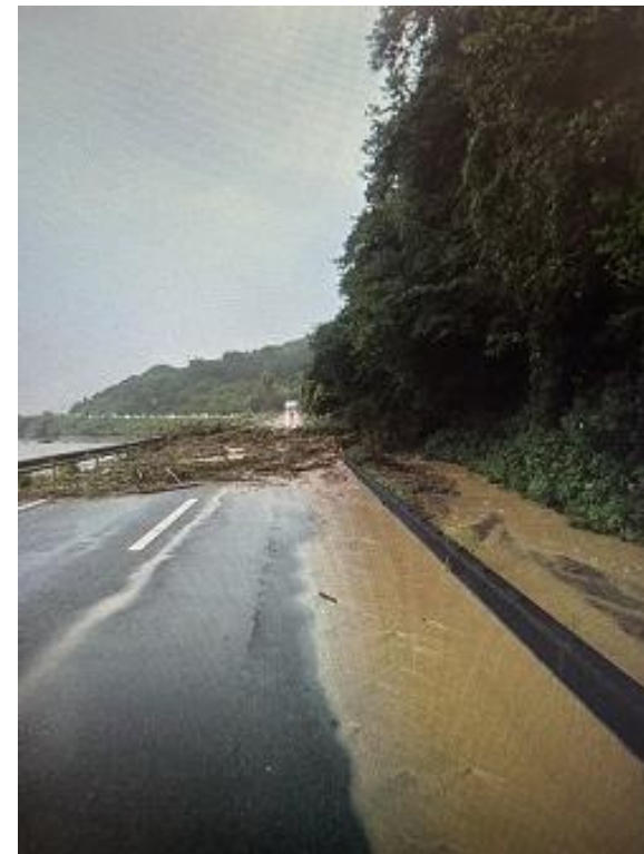
苓北町における土砂崩れ状況
