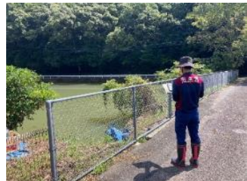
ため池緊急点検
