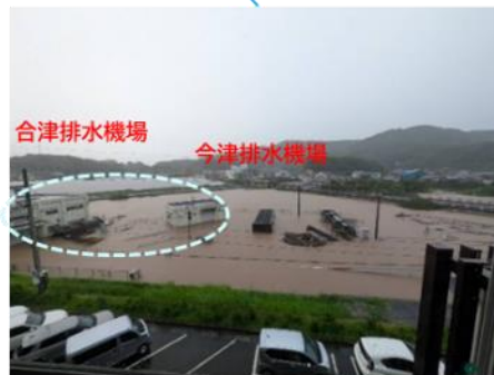
排水機場の浸水 【上天草市松島町】
