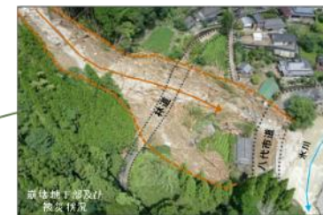
山腹崩壊 【八代市泉町下岳古屋敷】
