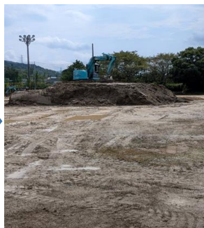
《復旧作業の状況》
