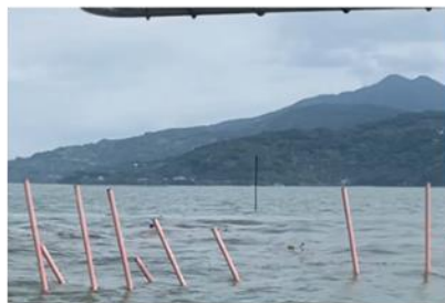
漂流物防止フェンスの流出・倒伏 【白川河口】
