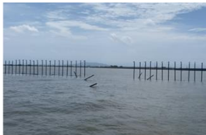
漂流物防止フェンスの流出・倒伏 【白川河口】
