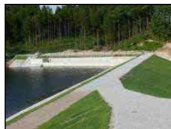
改修後のため池
