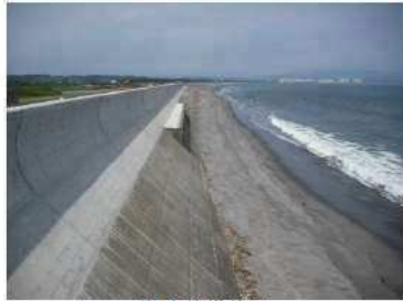
堤防整備状況
