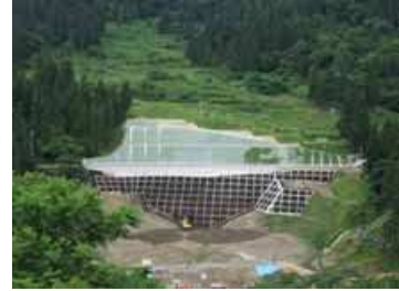
地すべり対策工事の完了
