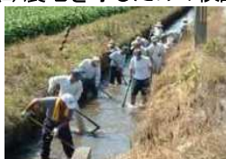
水路の泥上げ
