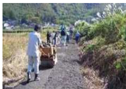
農道のアスファルト舗装
