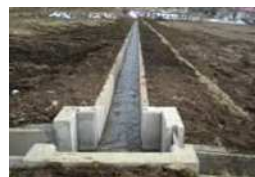
コンクリート水路への更新
