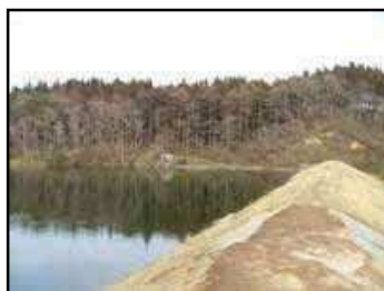
改修前のため池
