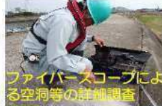
打音による空洞化調査状況
