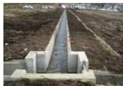
コンクリート水路への更新
