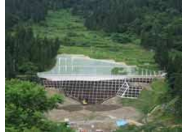
地すべり対策工事の完了
