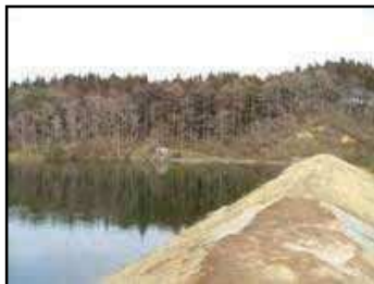
改修前のため池
