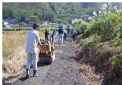
農道のアスファルト舗装
