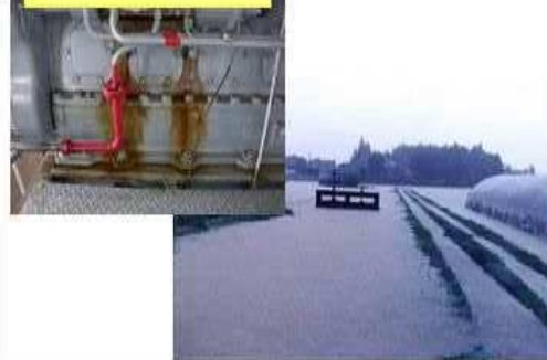
機器からのオイル漏れ
