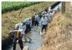
水路の泥上げ
