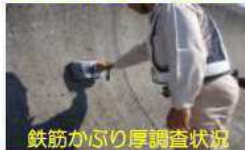
鉄筋かぶり厚調査状況
