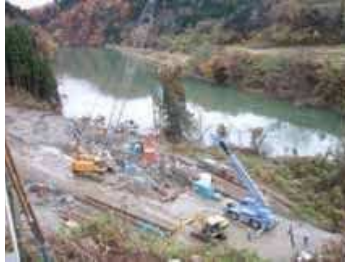
地すべり対策工事の実施
