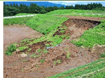
⑩農地の法面崩壊（菊池市）
