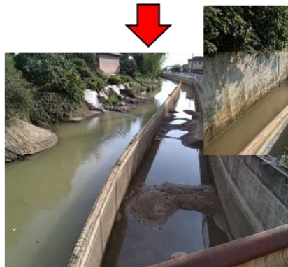
通水状況(用・排水路)(8月14日) 【八代市敷川内町】
