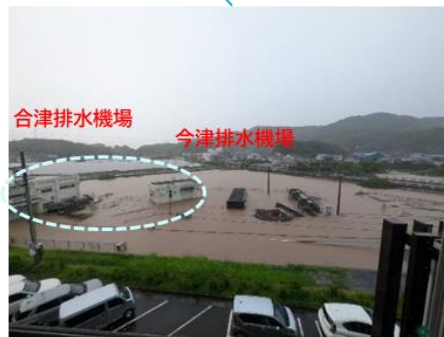
排水機場の浸水 【上天草市松島町】
