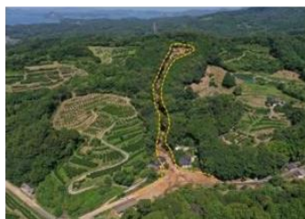
山腹崩壊 【天草市有明町赤崎切鮎】
