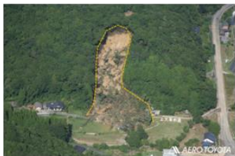
山腹崩壊 【上天草市松島町教良木川角】
