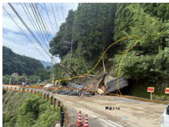
山腹崩壊 【美里町豊福肉伏】
