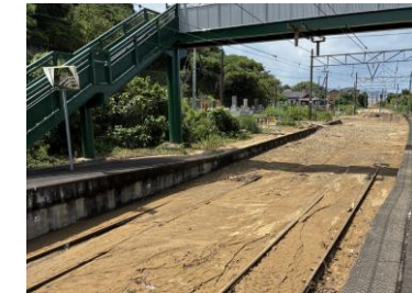
（肥薩おれんじ鉄道） 肥後高田駅近くの様子 （8/12 12時頃）
