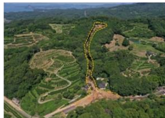
山腹崩壊 【天草市有明町赤瀬】
