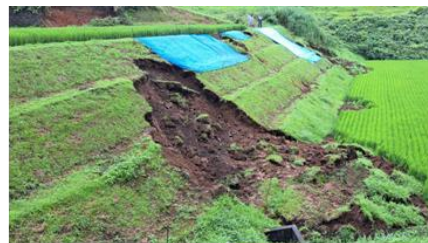
農地法面崩壊 【菊池市木庭町】
