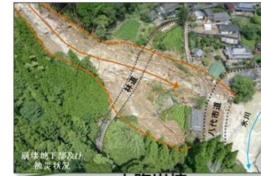
山腹崩壊 【八代市泉町下岳古屋敷】
