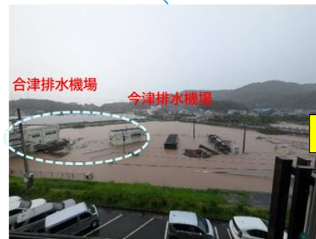
排水機場の浸水 【上天草市松島町】
