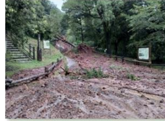
山腹崩壊 【熊本市北区立田陣内】
