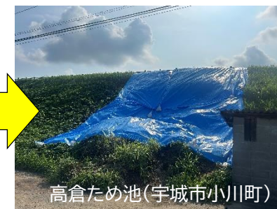
高倉ため池(宇城市小川町)
