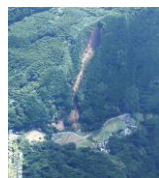
⑧山腹崩壊(美里町)
