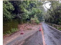
②国道443号（八代市）
