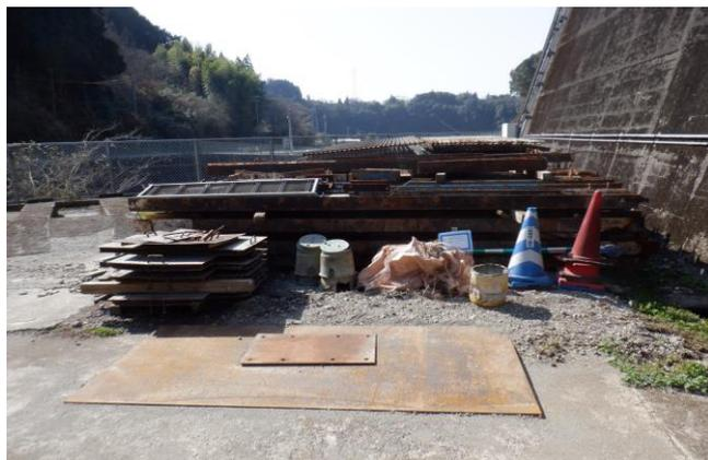
縞鋼板、鉄板及びその他切断部材等
