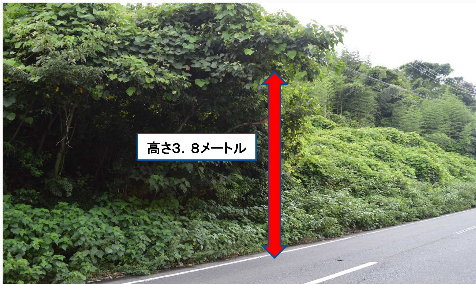
支障木の状況
