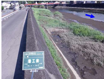
坪井川(施工前)
