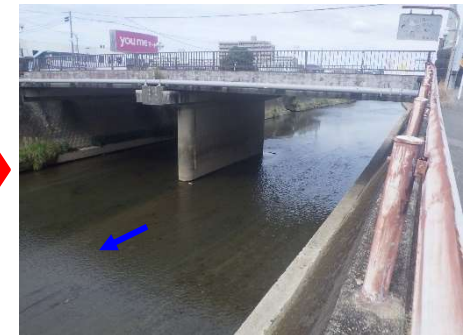
井芹川(施工後)
