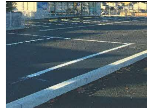
駐車場内の透水性舗装施工例
