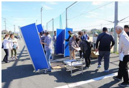
マンホールトイレの組立
