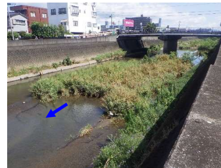
井芹川(施工前)
