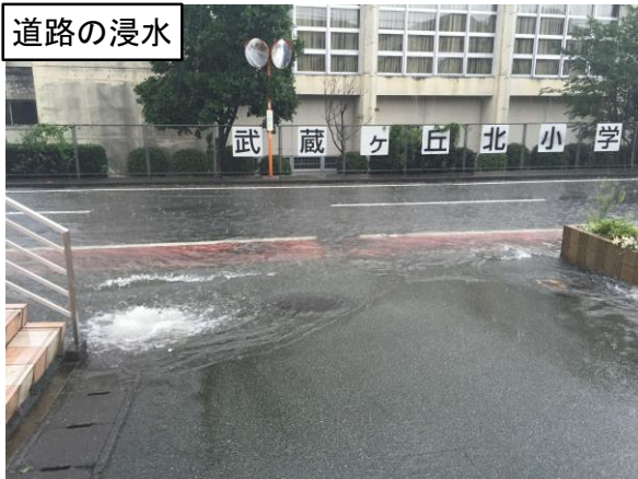
既設水路からの溢水
