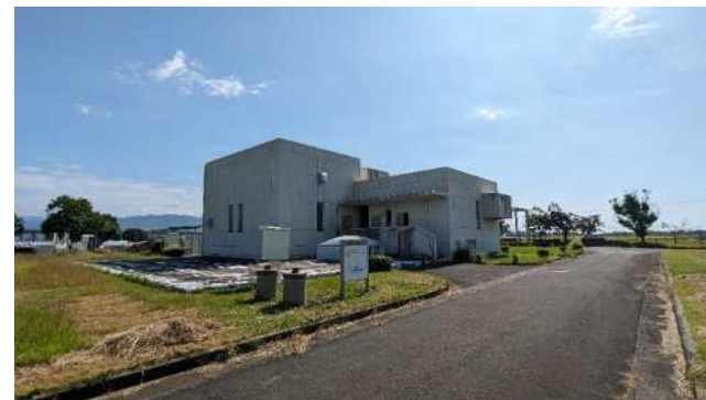
沈砂池・ポンプ棟
