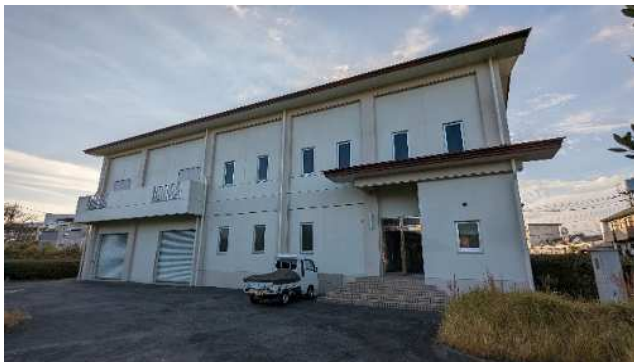
清水汚水中継ポンプ場
