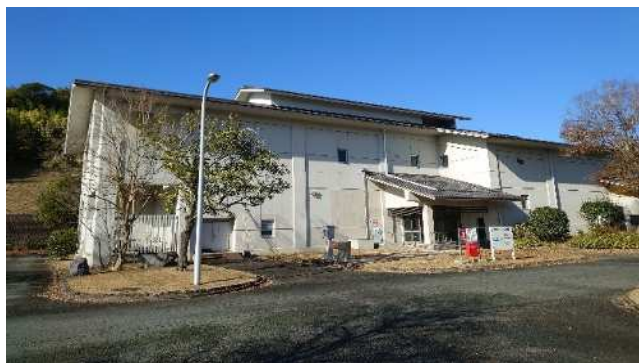
沈砂池・ポンプ棟
