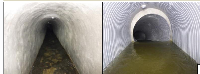
旧取水トンネル復旧(完了)
