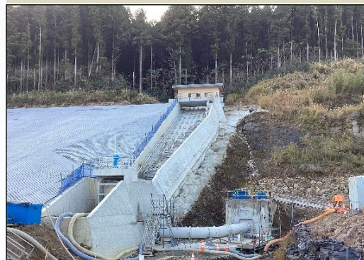
取水設備・操作室(完了)
