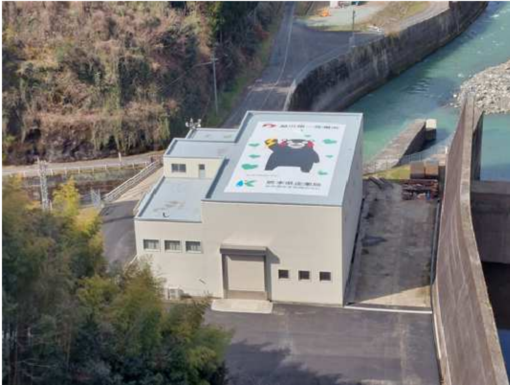
緑川第一発電所（下益城郡美里町）
