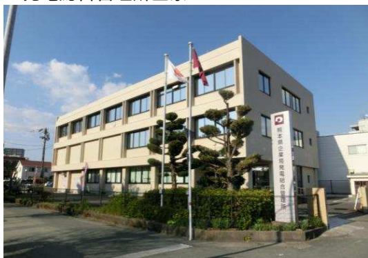
発電総合管理所全景
