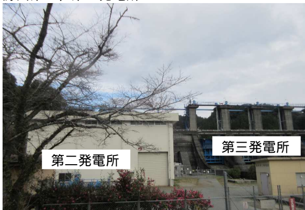
緑川第二、第三発電所
