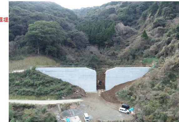
（支川）砂防堰堤施工箇所
