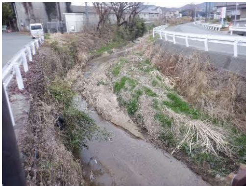
境川 河道掘削着工前
