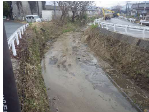
境川 河道掘削完了
