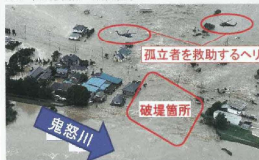
茨城県常陸市 鬼怒川堤防（写真：国土交通省）
