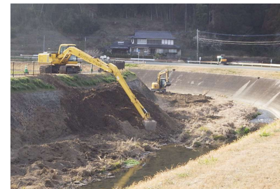
河道掘削イメージ
