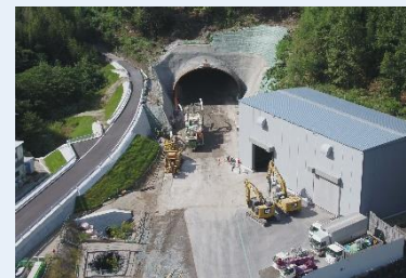
大矢野トンネルの整備
