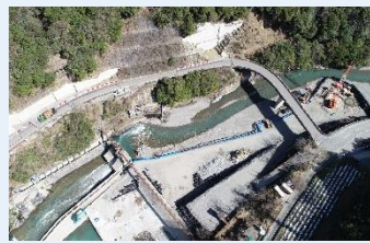
国道445号九折瀬工区(五木村)
