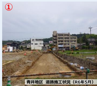
青井地区 道路施工状況 (R6年5月)
