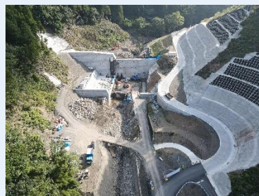
【砂防】川内川砂防堰堤整備(球磨村)
