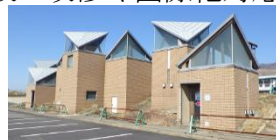
阿蘇山上公衆トイレの改修
