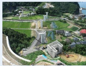
国道389号下田南BP(天草市)
