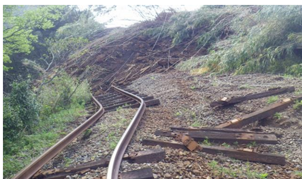
写真 激しい軌道変状
