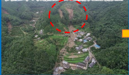
令和2年7月豪雨時の急傾斜地崩壊状況
