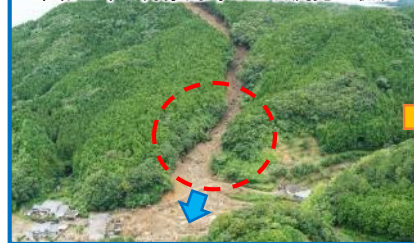
令和2年7月豪雨時の土石流発生状況
