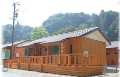
木造仮設住宅 (R2年8月完成時)
