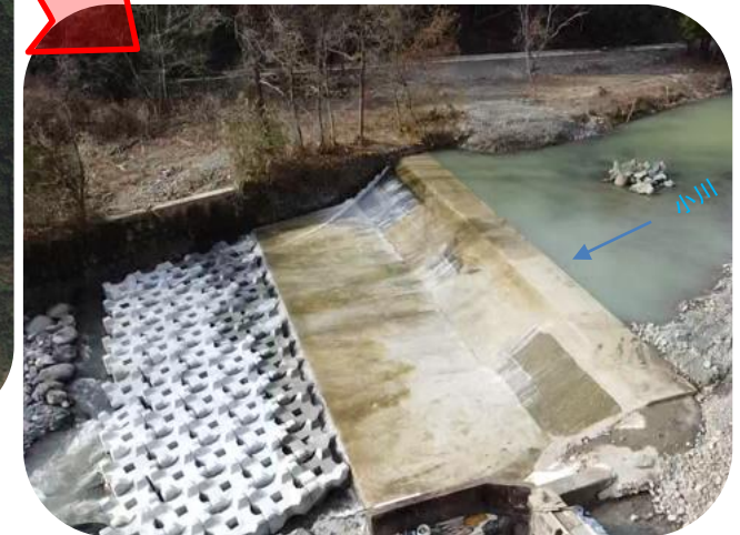
頭首工復旧完了
