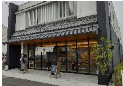
「緑屋本店」の復旧状況（人吉市）
