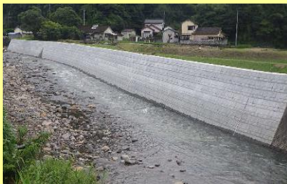
河川災害復旧工事(芦北町大川内)
