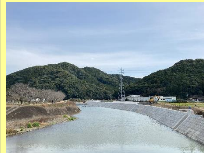
佐敷川改良復旧工事
