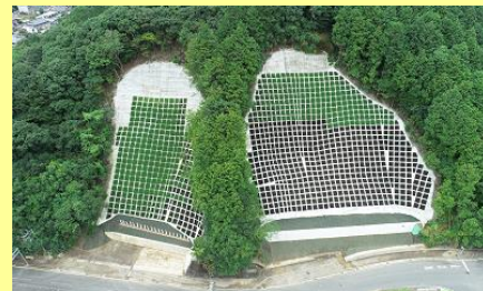
国直轄治山工事(芦北町女島)
