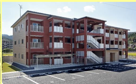
湯浦地区災害公営住宅
