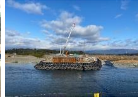
球磨川第4橋梁の工事状況 (R6.1.22)
