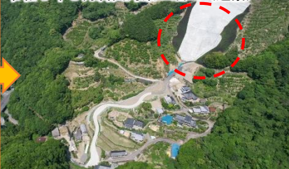
令和5年3月斜面対策工竣工(遠景)
