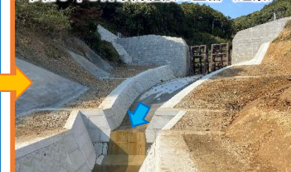
令和6年3月砂防施設の整備(近景)
