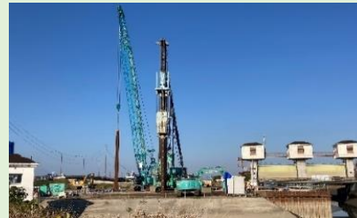
<松原地区 基礎工事(杭打設)>
