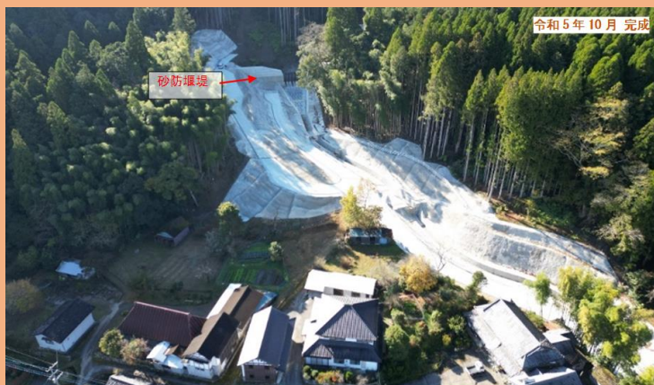
< 完成後の状況 >
