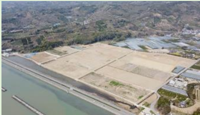
<大口西部地区施工状況>
