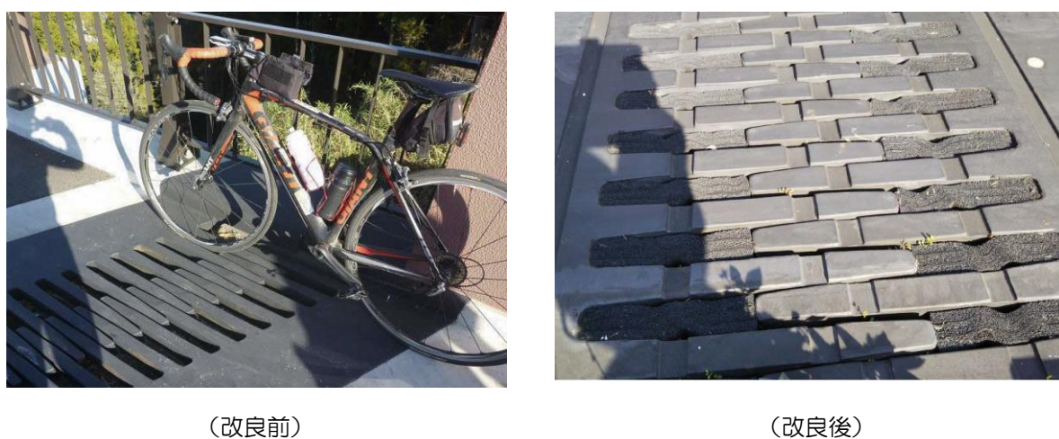
図表 41 グレーチング（側溝、集水ますやマンホールの溝）蓋の改良事例
